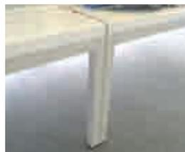
benachbarte Stützen ohne Zwischenraum, vorteilhaft zur Bodenreinigung
