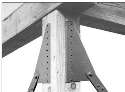
Detail an Eckstütze. Bandanschluss BNF25 mit Kopplungsverbinder BNKK25. Der gekantete Abschnitt des BNF25 ist in einem 70 mm von der Stützkante entfernten, 16 mm tiefen Schlitz eingelassen.
