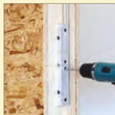
Schablone zum Vorbohren in Fräsnut einlegen
