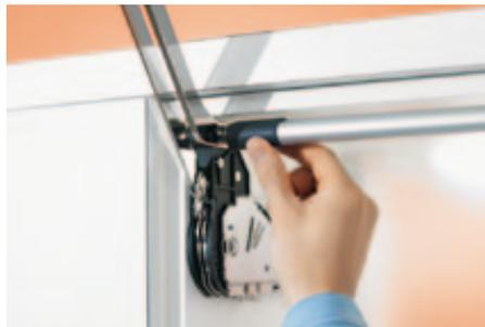
2. Für optimale Seitenstabilität wird die Querstabilisierung am Kraftspeicher montiert.
