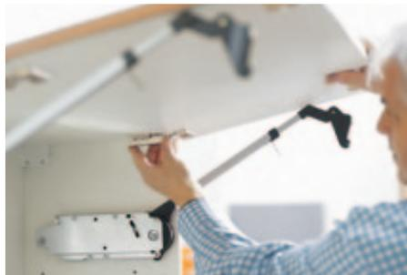
2. Die obere Front wird auf die Teleskophebel aufgelegt und die CLIP top-Scharniere werden befestigt.
