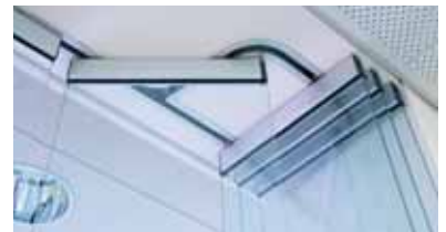
Ästhetische Integration der Laufschiene in die Decke mit Parkraumverblendung.
