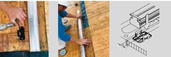
Montage de HAWA-Adapto : clouer les clips en plastique sur le coffrage de béton, enclipser le profil, bétonner, terminé.
