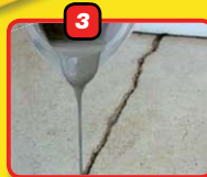
3 Die Mischung auf den Riss gießen und glattziehen mit dem Spachtel.
