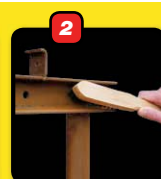
2 Elimination manuelle de la rouille et dégraissage
