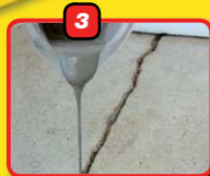
Verser le mélange dans la fissure et égaliser avec la spatule
